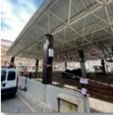
Şemikler Pazaryeri Boyama ve Çatı Değiştirme İşlemi
