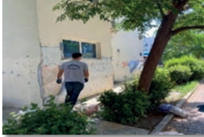
Nergis Muhtarlığı Duvar Tamirat ve Boyama İşlemi Proje Devam Ediyor
