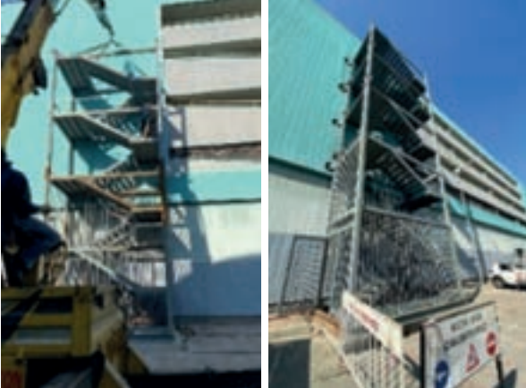
Çatı Bostanlı Yangın Merdiveni Yapım İşİ
