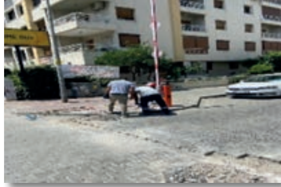
Bostanlı Barlar Sokağı Girişine Bariyer Takılması İçin Yapılan İşlemler
