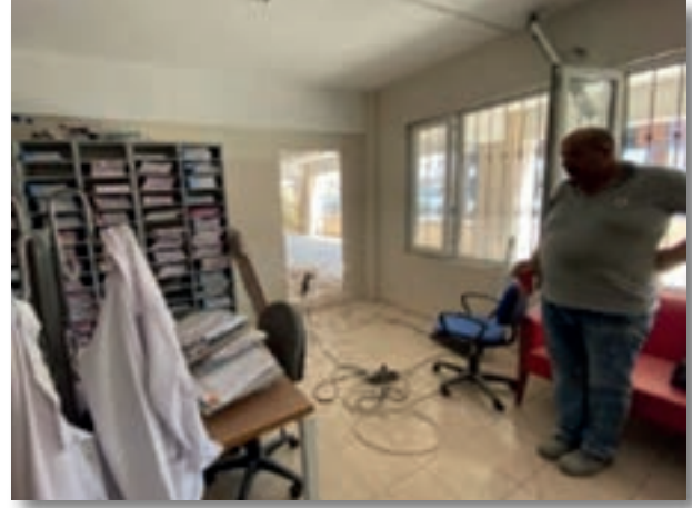
Kargem Öğretmenler Odasına Duvar Yıkım İşlemi ve Kapı Yapım Aşaması
