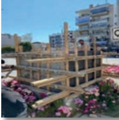
Girne Caddesi Atatürk Büstü için beton atım işlemi
