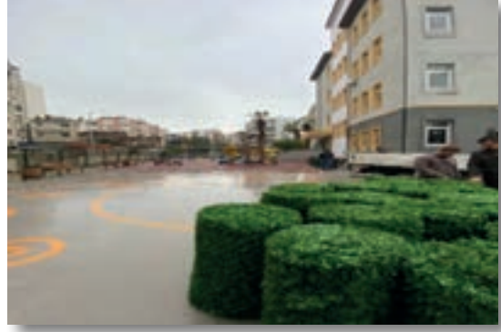
Cumhuriyet İlköğretim Okulu Bahçesine Çit Yapım İşi
