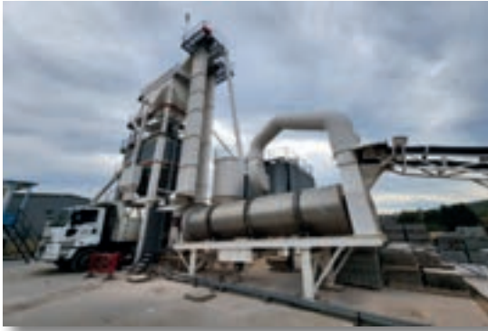
Asfalt Üretim Tesisi
