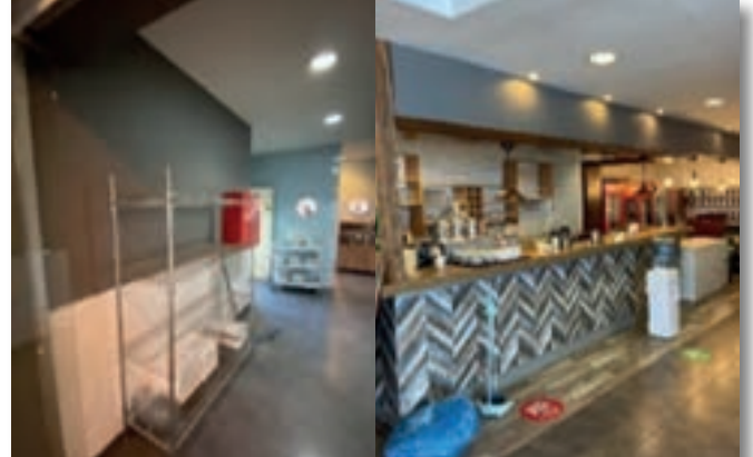
Kent Balık Restoran Tamirat ve Boya İşlemi
