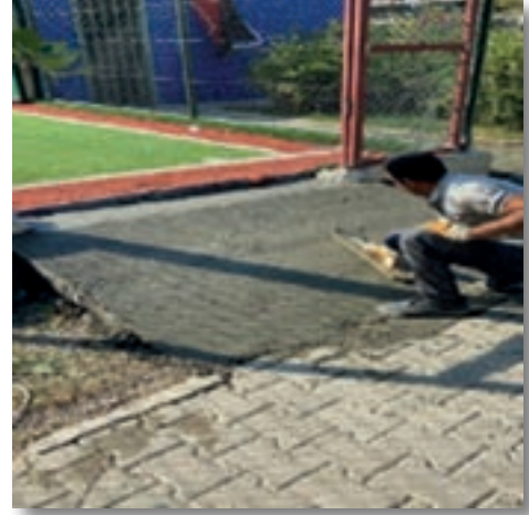
Muharrem Candaş Halı Saha Girişine Rampa Yapım İşlemi
