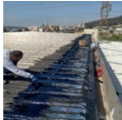
Şantiye Bakım Onarım Çatı Tamirâtı
