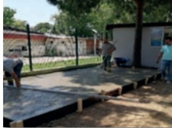
Bostanlı Park Bahçeler Müdürlüğü Depo Yapımı
