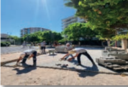
6286/7 Sokak Park Yanı Kilit Parke Yol Yapımı
