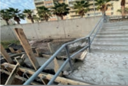
Soyak Siesta Alt Yoluna Merdiven Yapımı
