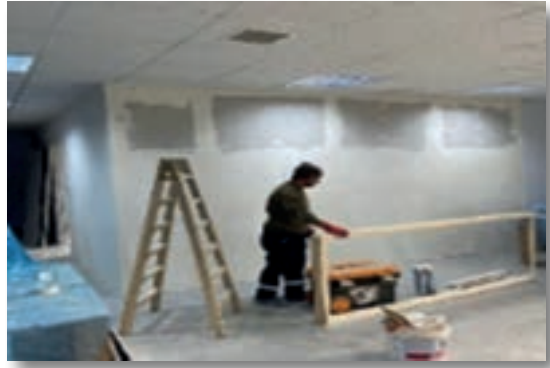
Deniz Baykal Kültür Merkezi Oda Yapım İşi
