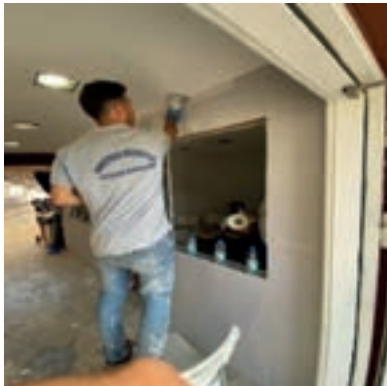
Suat Taşer Sanat Merkezi Müdüriyet Odası Yapım Aşaması
