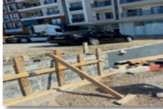
Anadolu Caddesi Carrefour Duvar Yapımı
