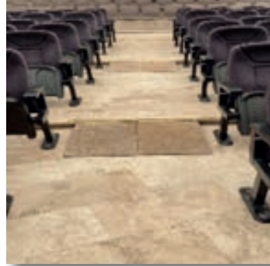
Suat Taşer Sanat Merkez Engelli Rampası Yapımı
