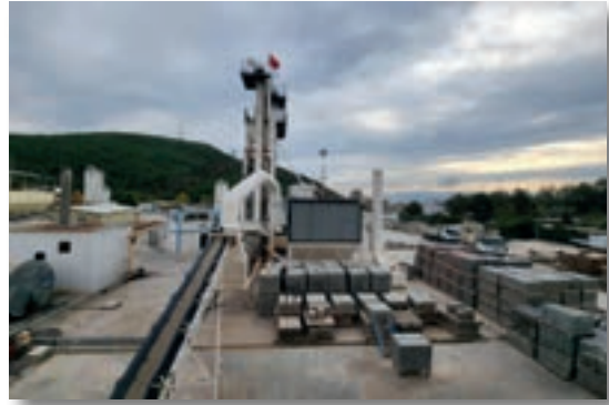
Asfalt Üretim Tesisi
