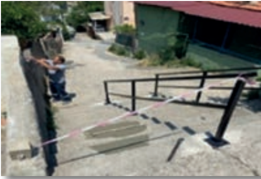
Cumhuriyet Mahallesi Merdivenlerine Demir Korkuluk Yapım İşlemi
