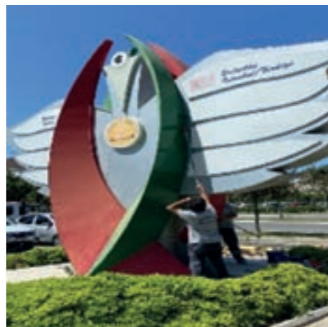
Hamza Rüstem Parkındaki Büstün Yenilenmesi ve Boyama İşlemi Yapılması
